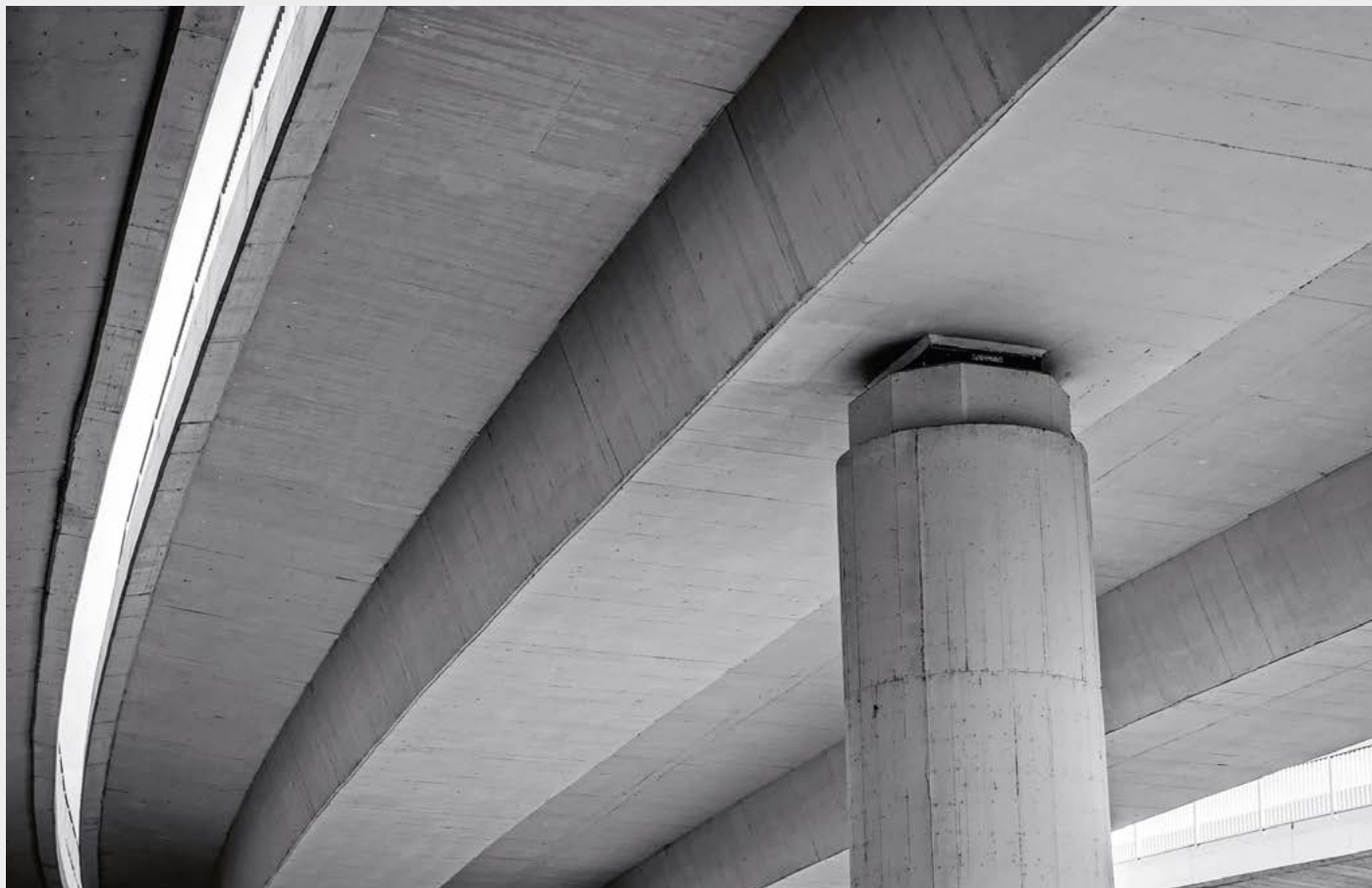
Teilbelastete Bereiche sind an fast jedem Bauwerk zu finden (Beispiel Betonbrücke).
